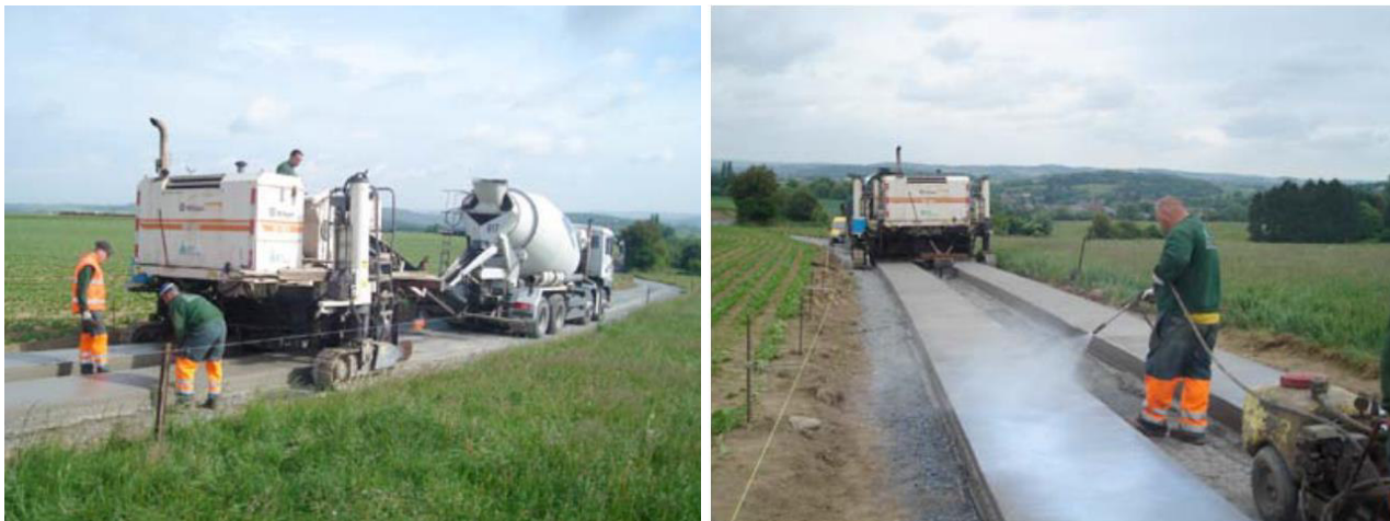
Figure 86 Illustration de la mise en œuvre d'une voirie bi-bande (source : Febelcem, 2011)
