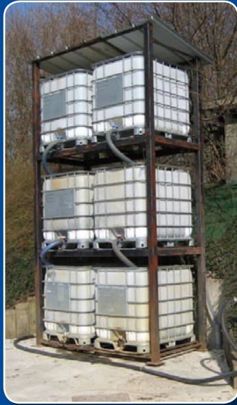
Exemple d'installation de traitement : Le biofiltre
