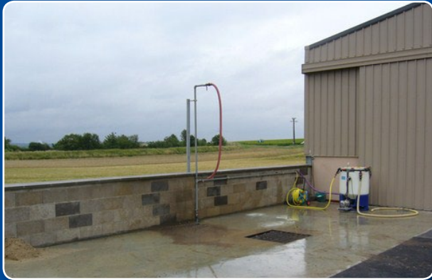
Sur une aire recouverte d'un matériau étanche et résistant mécaniquement et chimiquement en vue d'empêcher toute infiltration de PPP dans le sol
