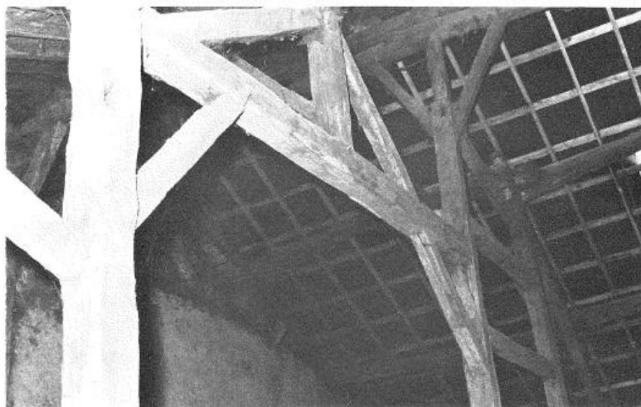
Figure 14 : VALANSART. Rue de la Cantelaine, 83. Partie de la charpente originale.
